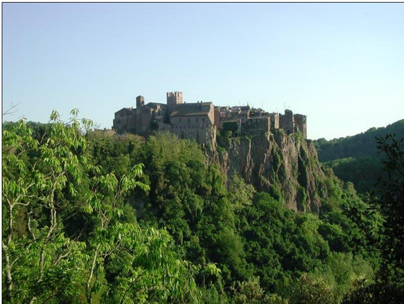
veduta di Calcata
